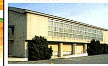
岩屋体育センター
